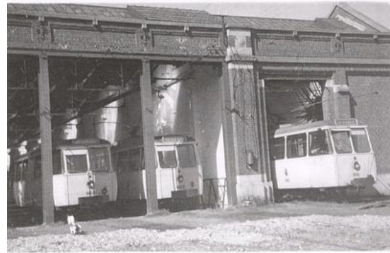
Le dépôt du "tram de Spa" à Tiège.
