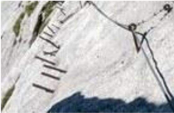
*Éléments de "via ferrata": câbles d'acier, échelons métalliques pour une progression verticale et "gués aériens" permettant une évolution horizontale.*
