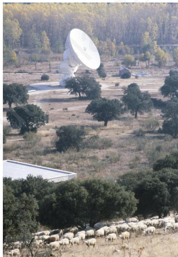
*Les antennes des stations de poursuite d'un observatoire spatial ne pointent pas vers les objets astronomiques observés, mais vers le satellite hébergeant le télescope. Ci-dessus, les antennes émettrice (en haut) et réceptrice de la station européenne VILSPA. On notera l'environnement bucolique dans une petite vallée du haut-plateau de Castille, protégeant autant que possible les installations des interférences de la civilisation.*
